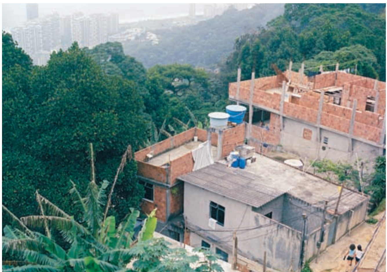
Conjunto habitacional com casas novas, em concreto e tijolo, na Rocinha, a maior favela do Brasil, localizada em um morro no Rio de Janeiro, praticamente construído por mutirão. Mesmo assim, o saneamento básico e a infra-estrutura são melhores do que na maioria das favelas do país, graças à sistemática intervenção da comunidade.
