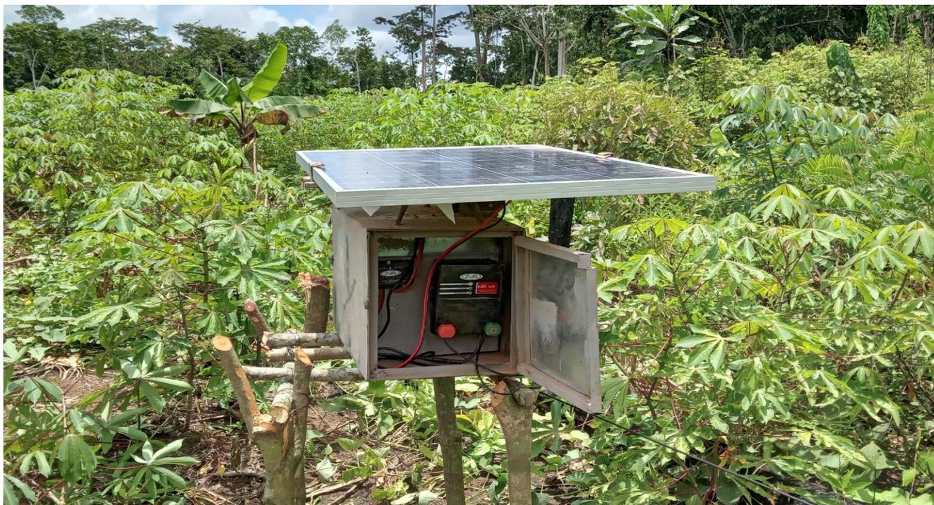
Un poste de clôture électrique mobile à énergie solaire doté d'un panneau solaire, d'une batterie, d'un boîtier de commande avec fil et d'une structure porteuse en bois. Photo crédit : Space for Giants.
