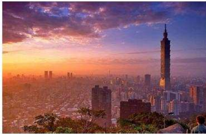
Fig. 15: Rendering, Taipei 101 [台北國際金融中心] (© C. Y. Lee Architects [李祖原建築師事務所] 2001)
